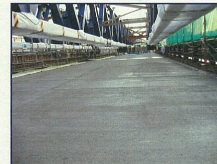
③ 上層床版(東側)のコンクリート打設完了 [10月4日(土)撮影]
