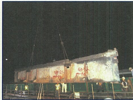
②上層主桁(西側)撤去状況[8月25日(月)撮影]
