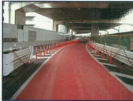
②5号池袋線(下)の車線切替状況[9月16日(火)撮影]
