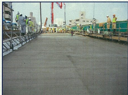
③上層床版(西側)コンクリート打設完了[9月6日(土)撮影]
