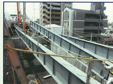
①上層橋桁(西側)運搬状況[8月31日(日)撮影] ②上層橋桁(西側)架設状況[8月31日(日)撮影]
