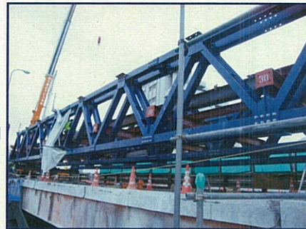
③架設用トラス桁設置[9月20日(土)撮影]
