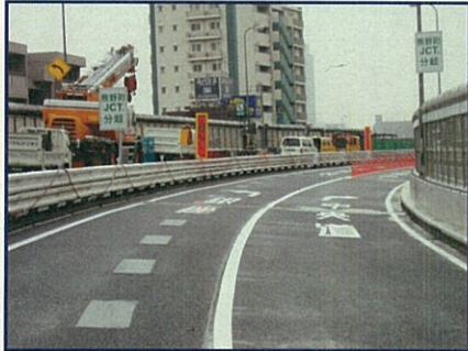
③5号池袋線(上)の車線切替状況[9月18日(木)撮影]
