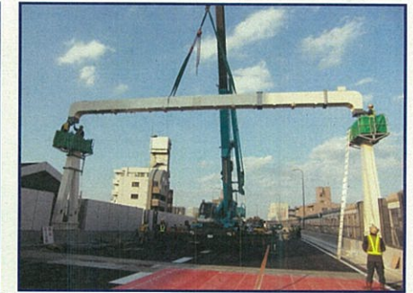
② 5号池袋線(上)の標識門柱設置状況 [10月13日(月)撮影]
