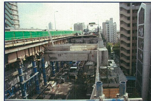
①上層橋桁・床版(西側)撤去状況[8月27日(水)撮影]
