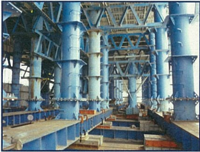
①仮支柱設置状況[8月7日(木)撮影]
