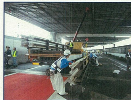
① 5号池袋線(下)の防護柵撤去状況 [9月30日(火)撮影]
