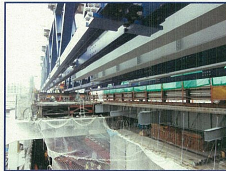
②上層橋桁(都心側・東側)架設状況 [9月23日(火)撮影]
