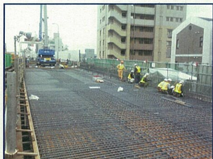
②上層床版(西側)鉄筋組立状況[9月4日(木)撮影]
