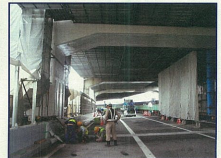
③橋脚補修完了[9月11日(木)撮影]
