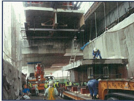
②上層橋桁・床版(東側)の搬出作業状況 [9月21日(日)撮影]
