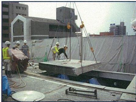
①上層床版(西側)撤去状況[8月20日(水)撮影]
