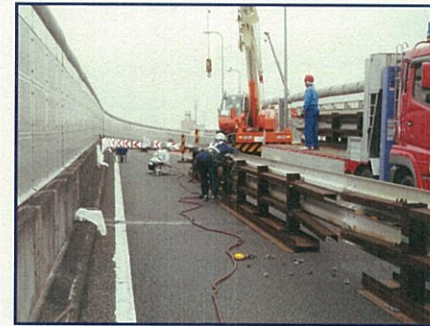
① 5号池袋線(上)の防護柵撤去状況 [10月12日(日)撮影]
