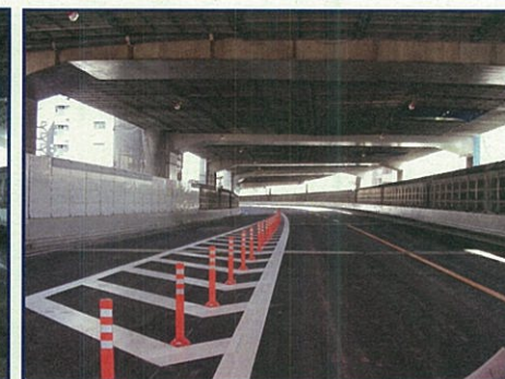
② 5号池袋線(下)の区画線設置状況 [10月2日(木)撮影]
