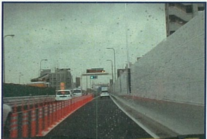
②山手トンネル(内)1車線開通及び5号池袋線(上)2車線開通(暫定運用) [9月18日(木)14:00]
