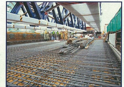
②上層床版(都心側・東側)の鉄筋組立状況 [9月27日(土)撮影]
