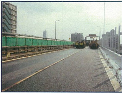
①5号池袋線(上)の舗装工事状況 [9月14日(日)撮影]
