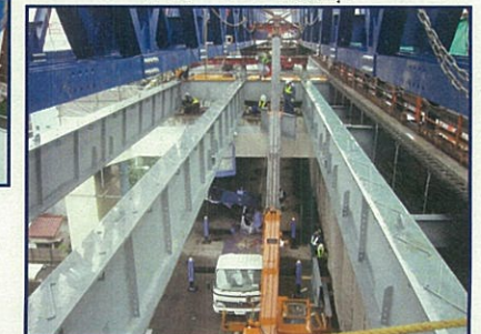
③上層橋桁(郊外側・東側)架設状況 [9月29日(月)撮影]
