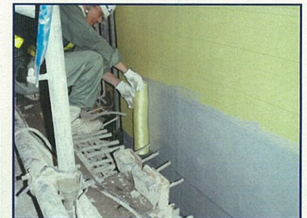
②橋脚のアラムド繊維補修[9月1日(月)撮影]
