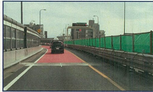
②5号線池袋線(上)1車線開通(暫定運用) [8月9日(土)16:30]
