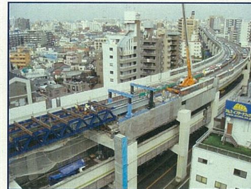
①上層橋桁(都心側・東側)架設状況 [9月23日(火)撮影]
