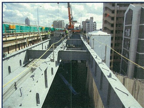
①上層橋桁(西側)の架設[8月31日(日)撮影]
