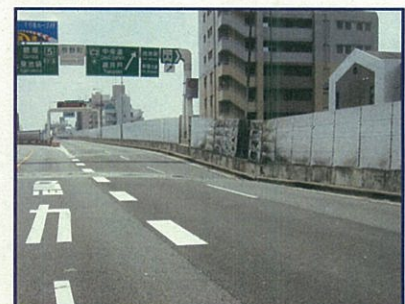
②上層橋桁・床版等の損傷状況
