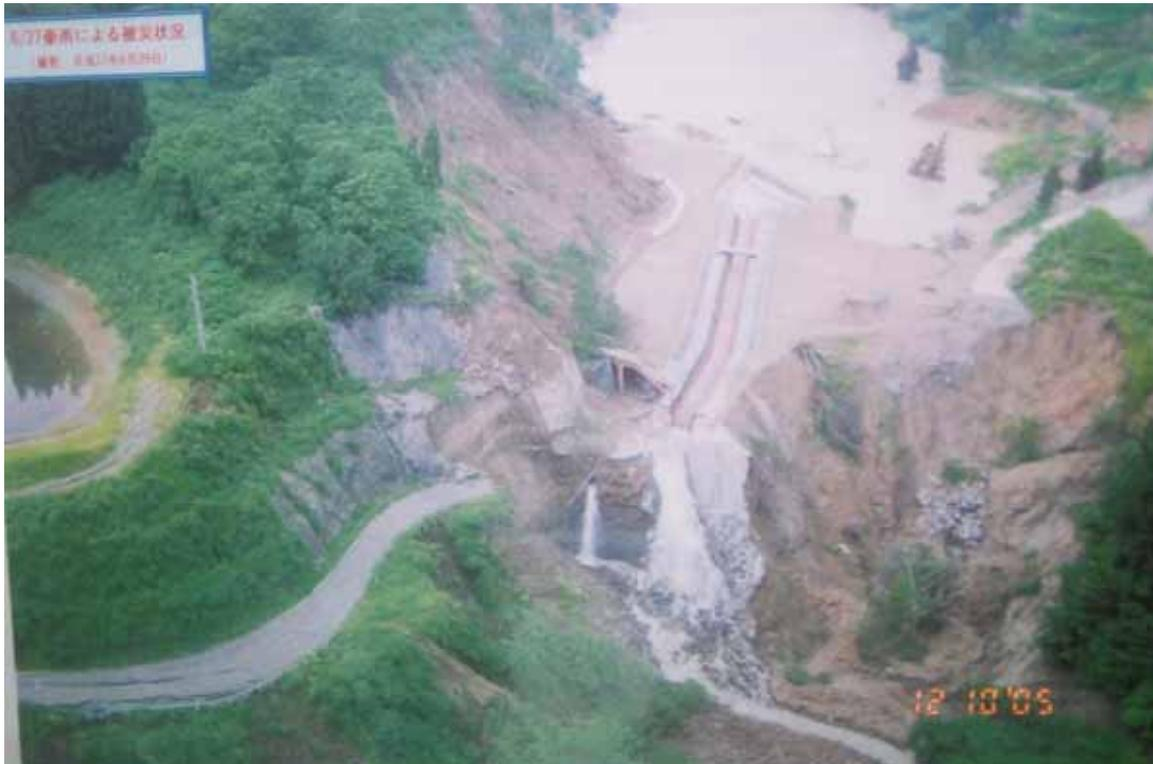
12/10 寺野(12) 展示写真 (平成17年6月、右岸崩壊発生時、漏水発生)
