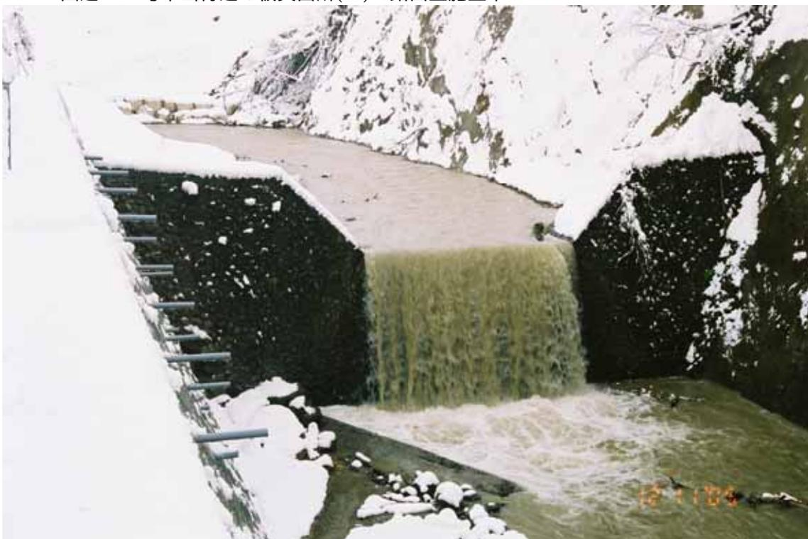
12/11 国道 291 号中山付近の被災箇所(44) 鉄筋コンクリート擁壁を撤去し擁壁を新設
