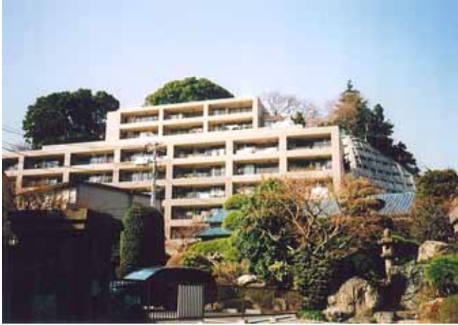
写真9 写真8の近くの地下マンションで、右横の斜面と一体化され、玄関は台地側にある。
