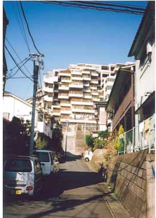
写真8 台地側では5階建て、低地側では10階建てのマンションで、玄関は台地側に設けられている。
