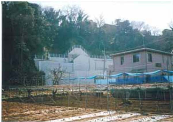
写真5 斜面の切土による宅地の造成と背後の土留め対策
