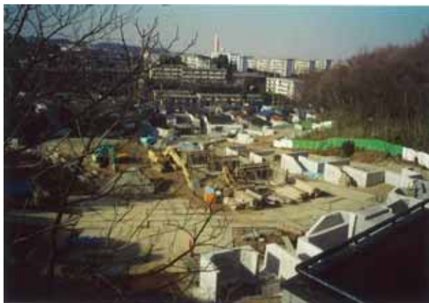
写真 1 谷間を埋め立てて宅地を造成し、住宅建設中の状況（2003 年）
