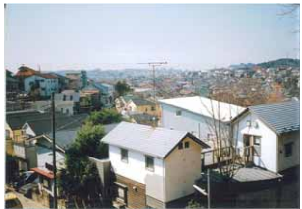
写真 2 谷を埋めた盛土の上に建設された住宅群（写真 1 の右手の山林から撮影）
