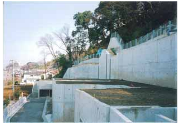
写真6 宅地造成の前は一連の斜面で、左の道路左端が斜面の末端であった。
