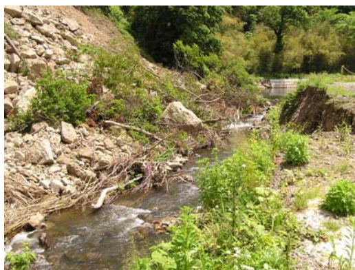
写真-4 崩壊土砂による河原田川の河道閉塞
