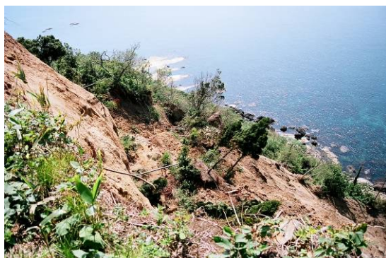
写真 4.11 深層崩壊の上部 崩土が残留。
