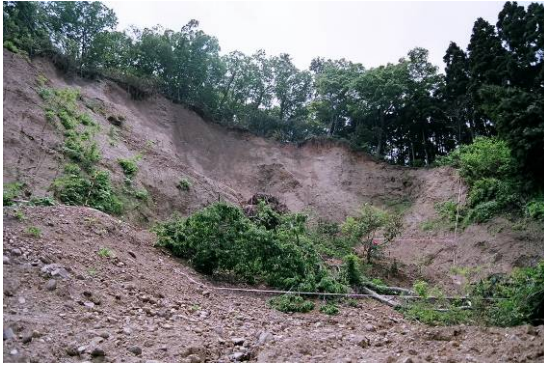
写真 4.39 滑落崖の崩落 (S-35) 林野庁所管地すべり防止区域「尺ヶ池」 施工されていた法枠工も崩落
