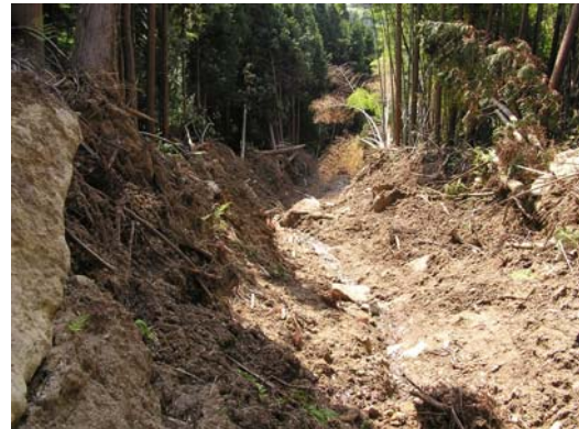
写真-7 カーブでも左右岸の高さの違いはない
