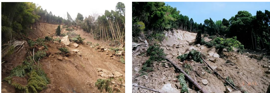
写真 4.19 崩壊地の状況（S-23） 左：4月1日後藤撮影 右：6月3日撮影 前回調査(4月)以降、中段に堆積した崩土（転石を含む）の一部が崩落した。
