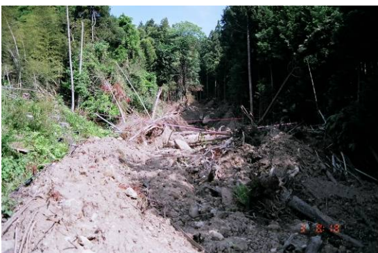
写真 4.30 崩土が流動化した流路の状況
