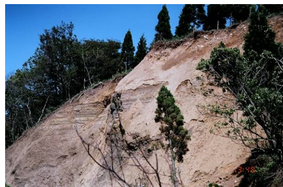
写真 4.12 滑落崖の状況
