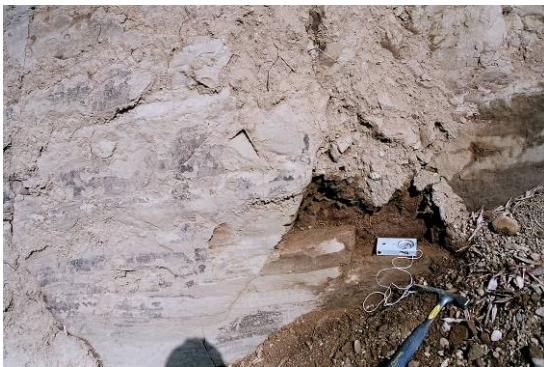
写真 4.22 凝灰岩の層理面 水平に近い受盤の斜面である。
