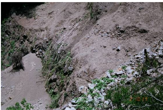
写真 4.3 崩壊地下部の礫岩の露頭
