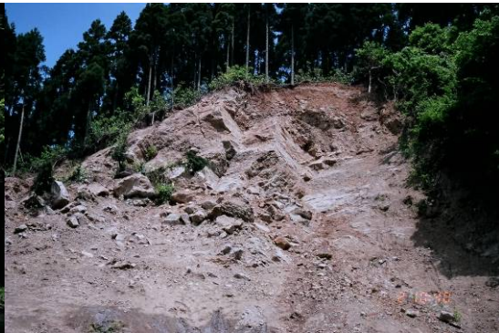
写真 4.2 くさび状に岩盤が崩落した上部
