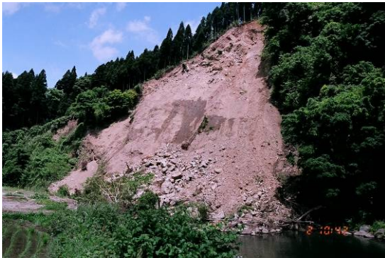
写真 4.1 河岸に発生した深層崩壊 (S-27)
