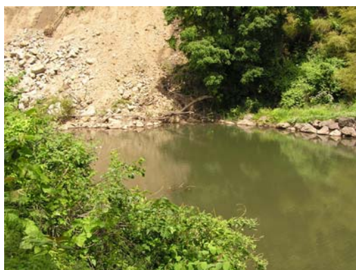
写真-5 河道閉塞上流の湛水状況
