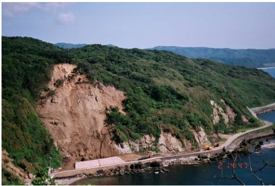
写真 4.5 市道沿いの斜面崩壊
