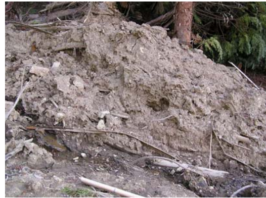
写真-5 土石流堆積物の状況：泥流の侵食跡あり
