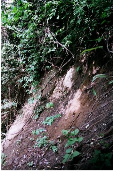
写真 4.26 林内にある旧滑落崖
