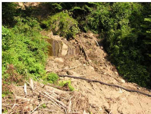
写真-1 治山堰堤に捕捉された土石流
