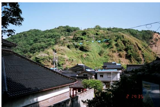
写真 4.13 背後斜面（左岸側 S-30）の状況
