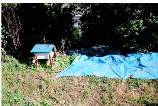
写真 4.15 応急対策が行なわれた背後斜面 （S-31, 亀裂をシートで保護）
