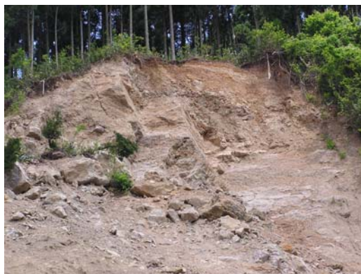
写真-3 崩壊上部の岩盤崩壊部分
