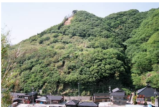
写真 4.14 背後斜面（右岸側 S-31）の状況
