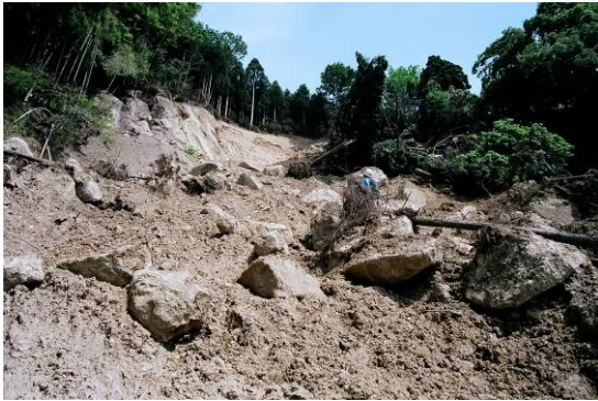
写真 4.20 中段の崩土の状況 凝灰角礫岩の岩塊が見られる
