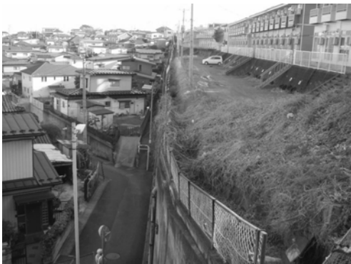
写真5 末端部の大規模な擁壁と盛土
