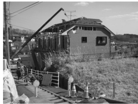
写真7 大きなアパートが傾き、解体中
