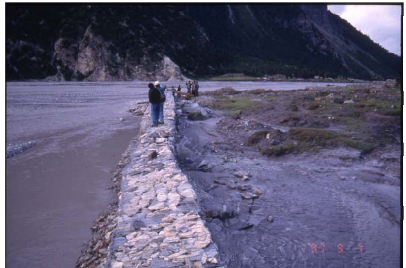
地すべり地の河川上流側への水制の設置 (Sept 1997)
