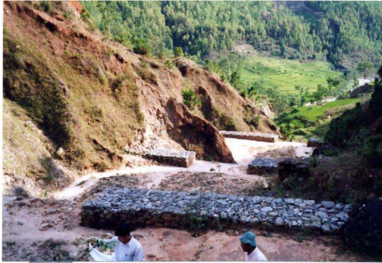
ふとんカゴ砂防堰堤によるガリー侵食対策(1995)
