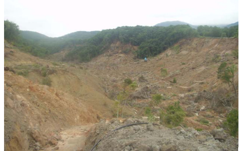
耕英地区冷沢では多数の崩壊・地すべりが発生
