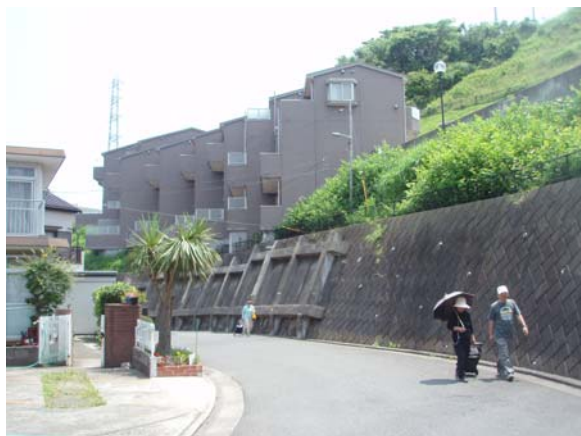
擁壁を補強して斜面に建設された集合住宅
