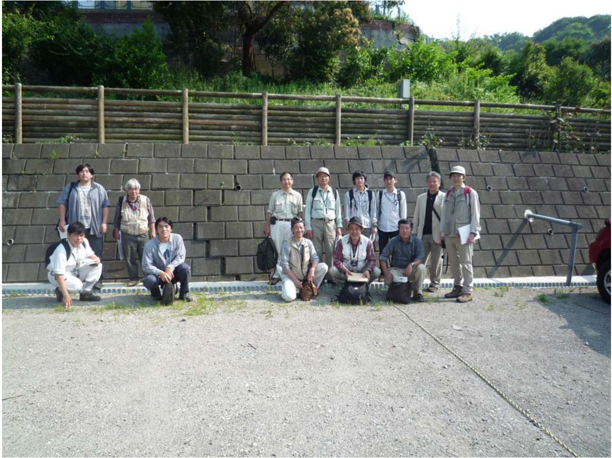
地すべりにより変状したブロック積擁壁をバックに巡検参加者（矢部満撮影）
