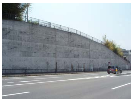
左：地すべり対策としての横ボーリング孔による排水工 右：道路は柱列杭による土留め工を採用
