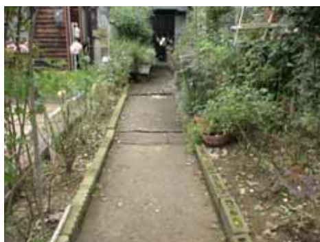
向陽町内の谷埋め盛土地盤内に何列も入る引っ張り亀裂。家屋は外観上大きく傷んでいないが、中は傾いており被害は大きい。
