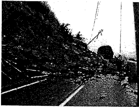
写真 5.1.4 表層崩壊と落石(S-14 地点)
