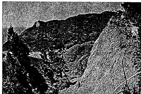
写真 4.10 深層崩壊の滑落崖
