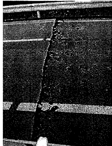
写真 5-2-23 着目した盛土の谷側の亀裂
