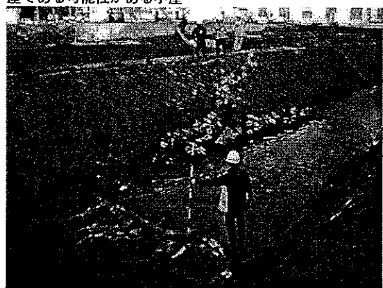
写真 4. 4 小崖沿いの破損した流路工
