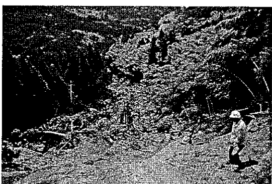
写真 4.25 崩壊地上部から下方の状況
