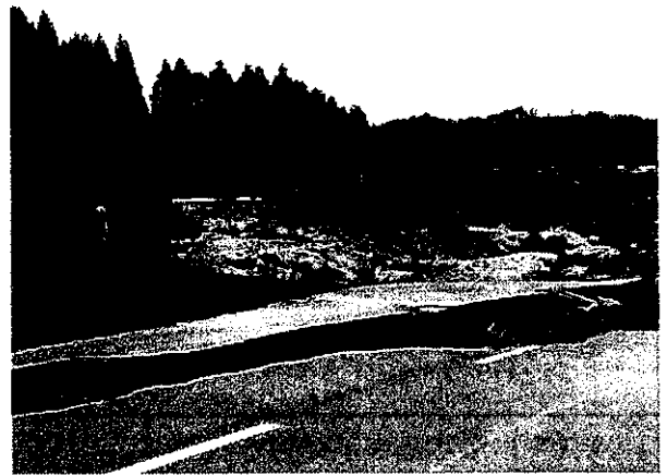
写真-5 川裏法面崩壊部(薩摩川内市東郷町)
