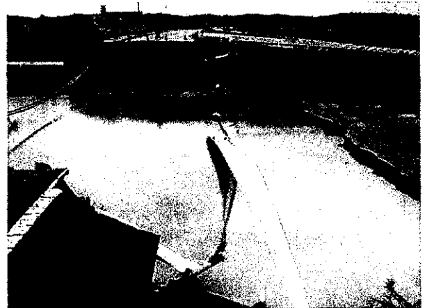
写真-5 川裏法面崩壊部(薩摩川内市東郷町)
