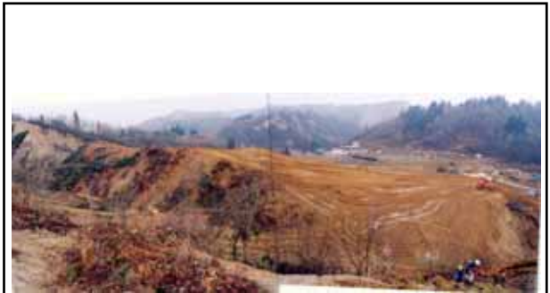
地すべり土塊の二次移動防止のための切土施工 (東竹沢地すべり土塊頭部における切土状況)
