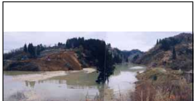
芋川本流と前沢川の合流点、右手は東竹沢地すべり - 台船による資材輸送には限界がある。 - 合流点付近で前沢川を陸路横断するために埋立工事中、
