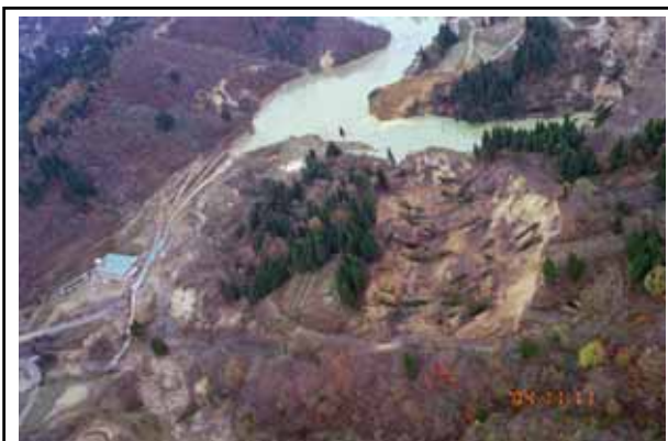
東竹沢地すべりにより形成された貯水池からの緊急排水の状況 (11月11日撮影)
