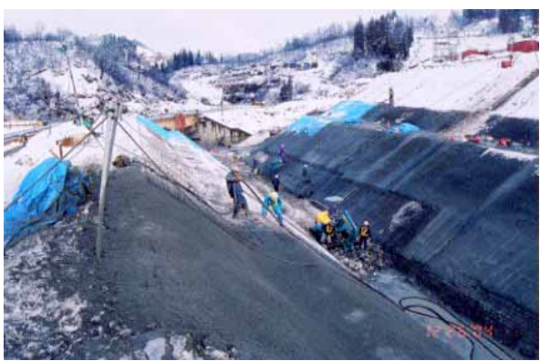
融雪出水にも対応可能な十分断面を有する仮排水路
