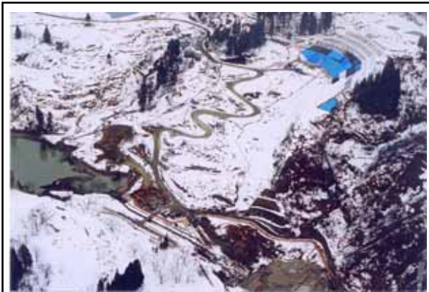
寺野地区地すべりダム安定化工事 (約1年後の状況)
