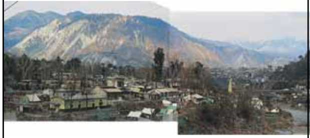
ムザファラバード市街地北西部の大規模表層崩壊
