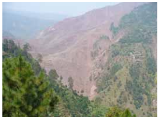
下流側から見た地すべりダムの堆積状況
