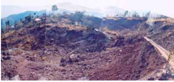
地すべりによる道路崩落箇所 (首都イスラマバードから被災中心地ムザファラバード間)
