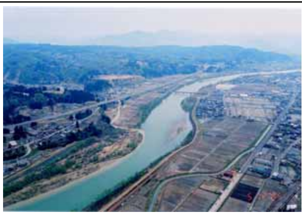
芋川と魚野川との合流点の状況。芋川からの流入水の濁度が高い。(5月12日撮影)
