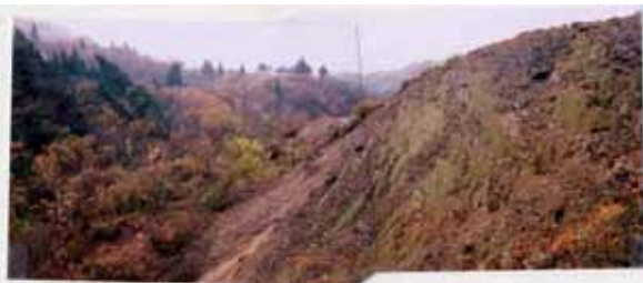
東竹沢地すべり末端部の状況(11月3日撮影)
