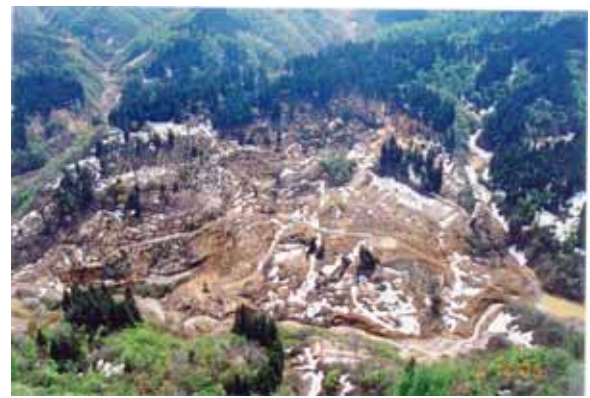
芋川流域における大規模地すべりと河道閉塞箇所状況(5月12日撮影)
