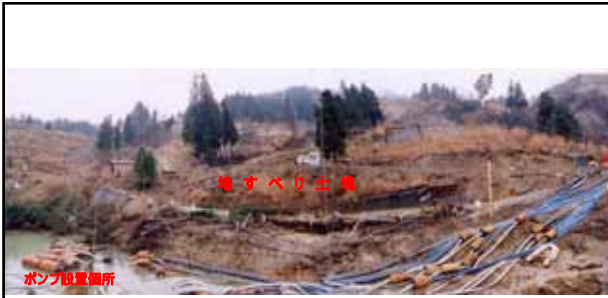
ポンプによる緊急排水状況 (寺野地すべりダム)
