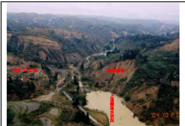
寺野地すべりダムと河道閉塞状況 / 上流側より下流側を臨む (10月27日撮影)
