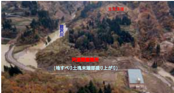
東竹沢地すべりダムによる河道閉塞状況 / 正面写真(11月2日撮影)
