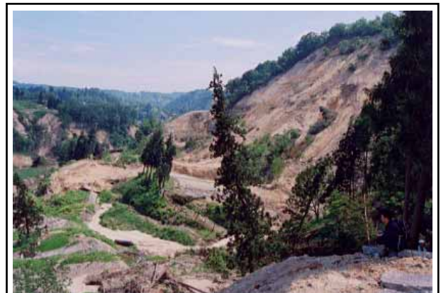
南平地区芋川右岸/崩壊斜面の融雪による拡大崩壊
