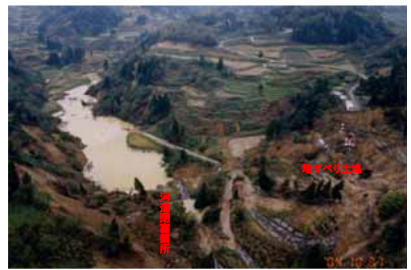
寺野地すべりダムによる河道閉塞状況 (10月27日撮影)
