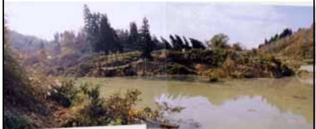
東竹沢地すべり側面写真(上流側)(11月3日撮影)
