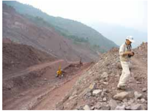
地すべりダム上の開削水路
