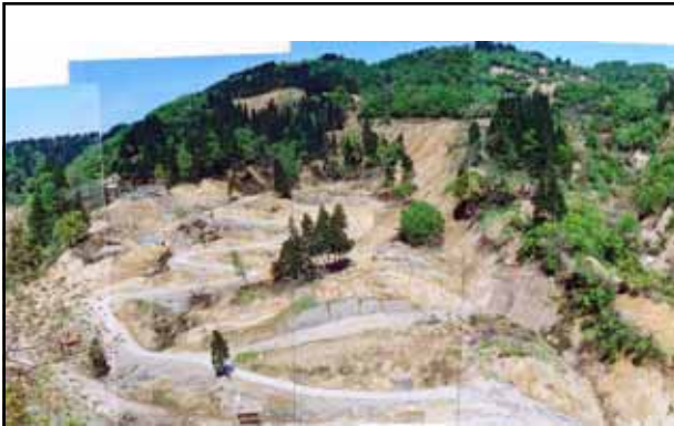
寺野地区地すべり全景(5月17日撮影) 地すべり地内は整形され、工事用道路には舗装が施されている、変状は見られない。
