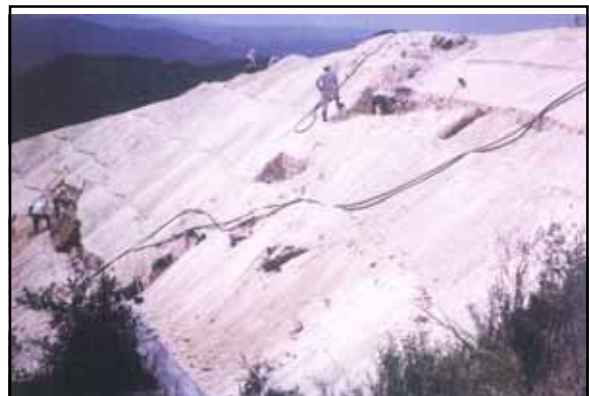
山腹工, 段切り
