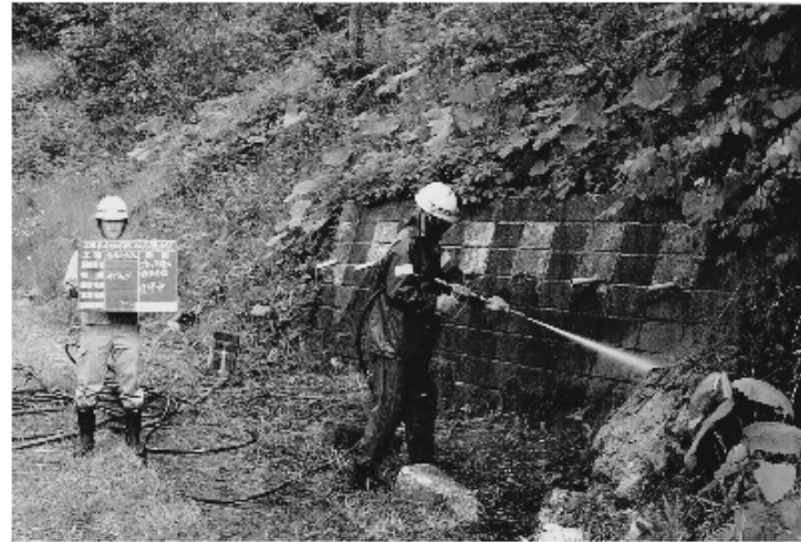
写真4 壁面と目地等の超高压水洗浄状況
