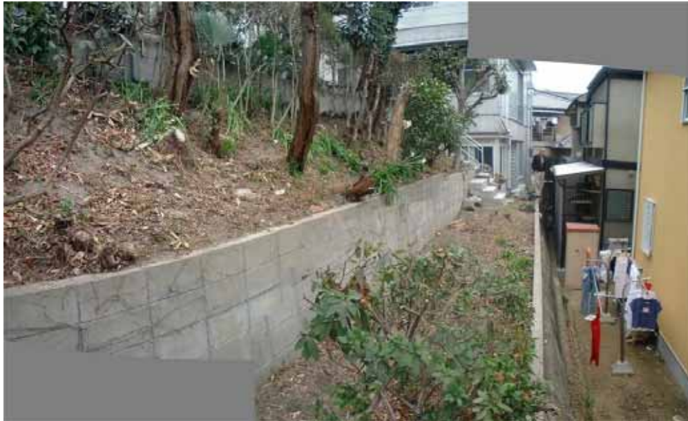
写真 1 既存不適格斜面の補強対策事例
