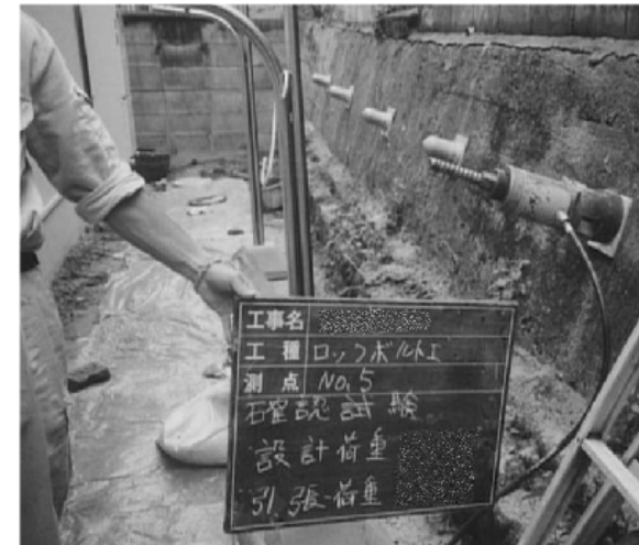
写真 1 既存不適格斜面の補強対策事例
