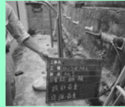
既存不適格斜面の補強対策事例
