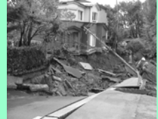
2004年新潟県中越地震で発生した宅地谷埋め盛土の崩壊事例
