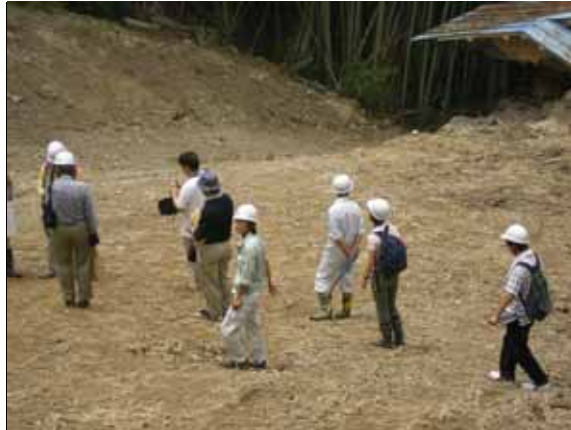
STOP 3 (高松市三谷町): 崩壊対策後の状況。
