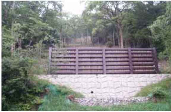
STOP 1 (高松市峰山) 崩壊対策後
