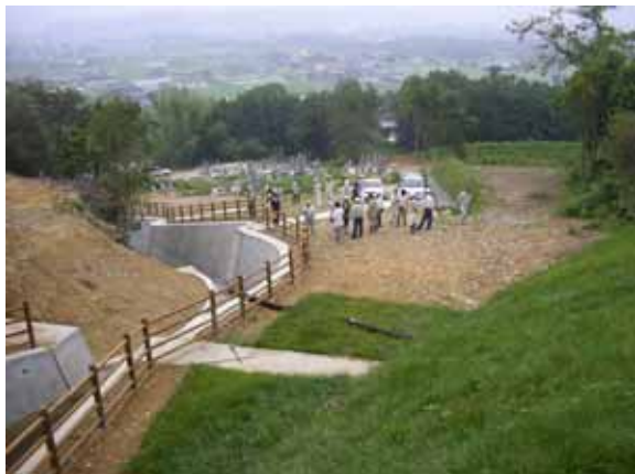
STOP 2 (満濃町長尾): 土石流対策後の状況。
