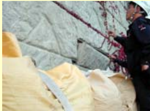
飛び出したスキン
