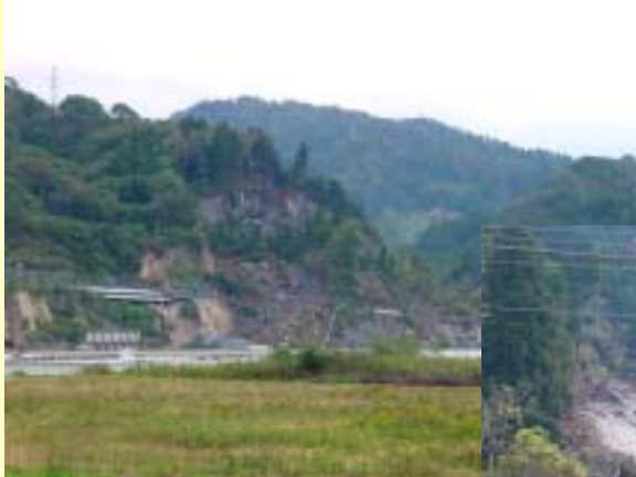
旧国道ごと崩落 (妙見)
