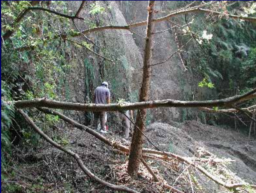
今回崩壊箇所
