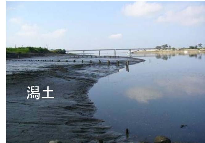
写真-1 石積水制から下流に見た潟土の堆積状況
