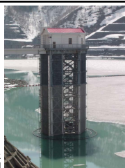
選択取水設備の例
