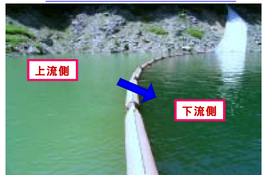
図 3 フェンス上下流の濁りの様子
