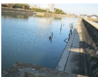
写真1. 新池川水門外側
