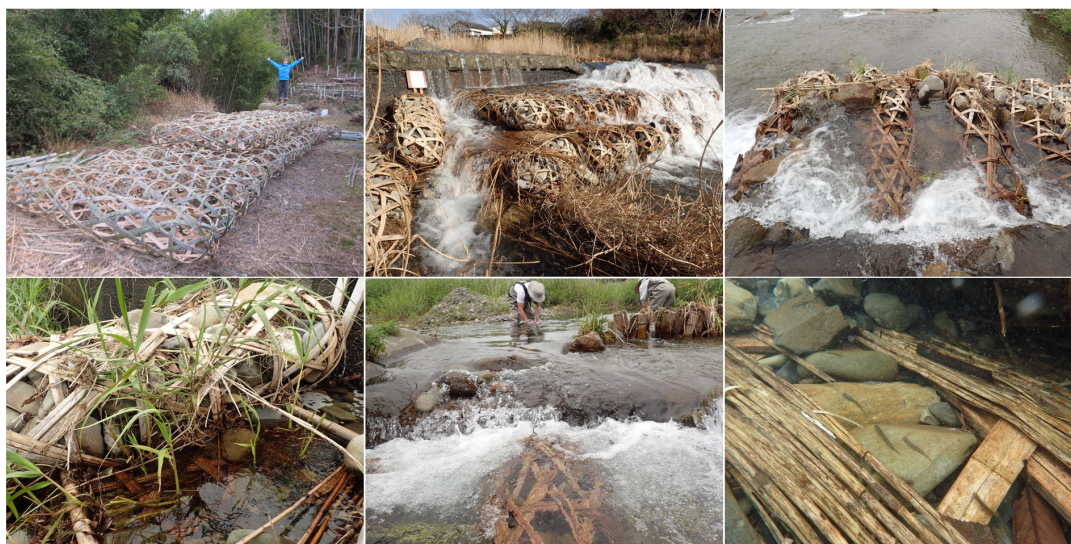
図3 竹蛇籠の製作と魚道設置状況
