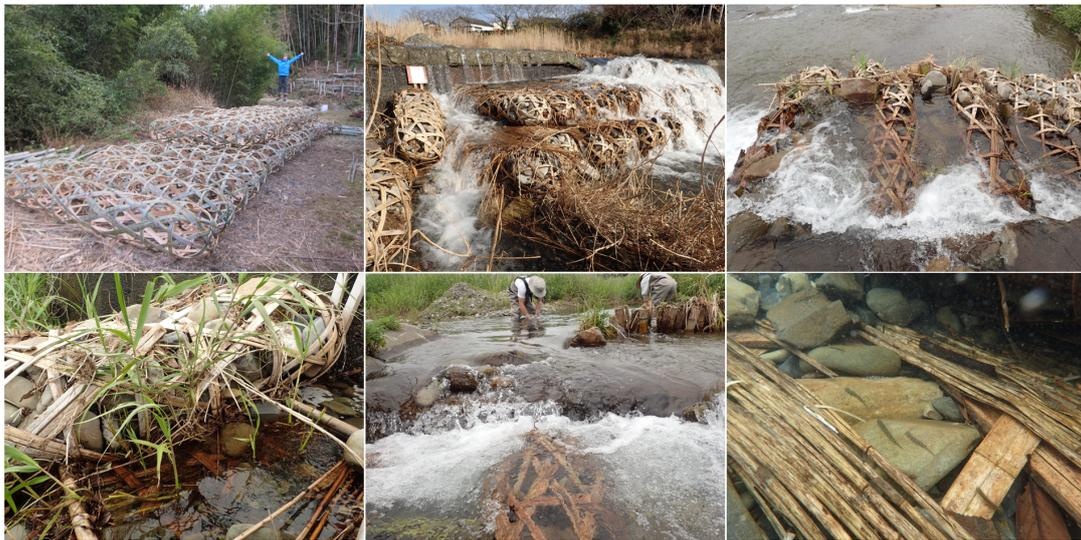
図3 竹蛇籠の製作と魚道設置状況
