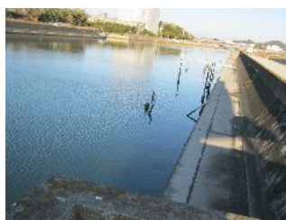
写真1. 新池川水門外側
