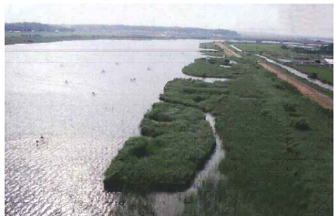
図2 北須賀工区整備状況
