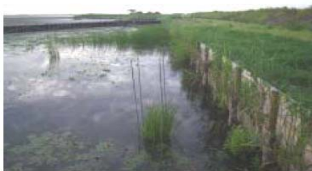
図 3 八代 1 工区整備状況
