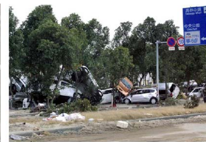
図 I-10 樹林帯が漂流物を捕捉 出典: 日本公園緑地協会 東日本大震災における公園緑地等の利用実態等の調査より
