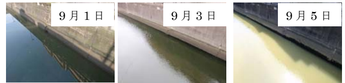
写真 4 出水後の S 橋における経日変化
