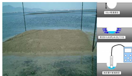
図-7 干潟域クリンカ覆砂状況及び水質調査概要
