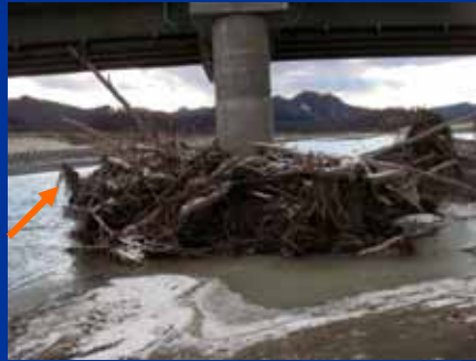
貫気別橋橋脚のアップ(上流正面)
