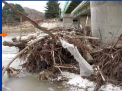
貫気別橋橋脚のアップ(側面)
