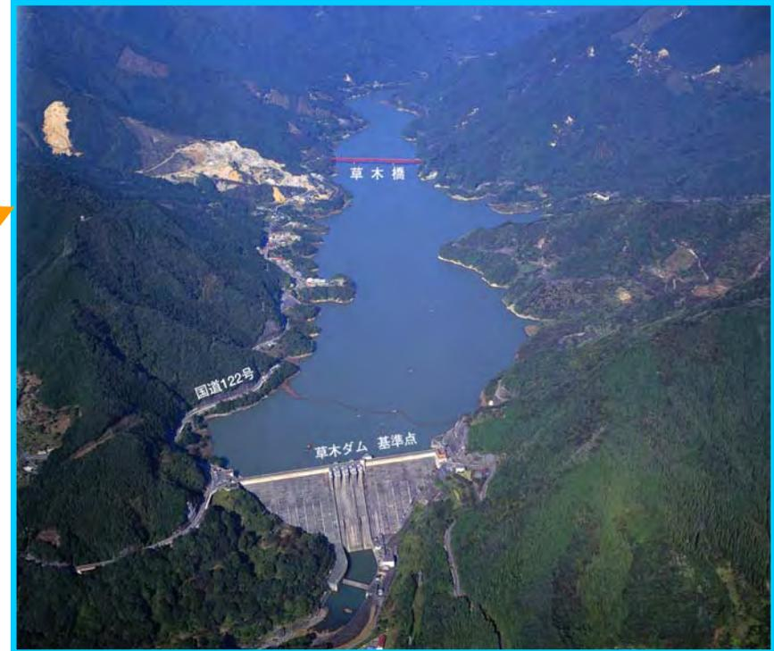
草木ダム(集水面積:254km<sup>2</sup>)における現行の操作規則は昭和52年の建設当時に定められており,それによるとダム湖への流入量500m<sup>3</sup>/s以上を洪水と定義し,放流量はこの式で決定される.
