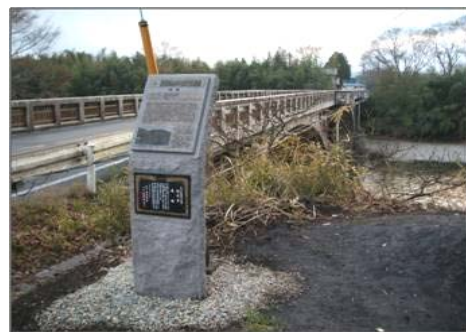
写真 1 境橋の橋詰に設置された解説板。 2007 年度土木学会選奨土木遺産の認定書も 取り付けている。(雨水による劣化への対応 から、現在はアルミ板にコピーし石材に埋め 込むエレクトリックビームに改良した。)
