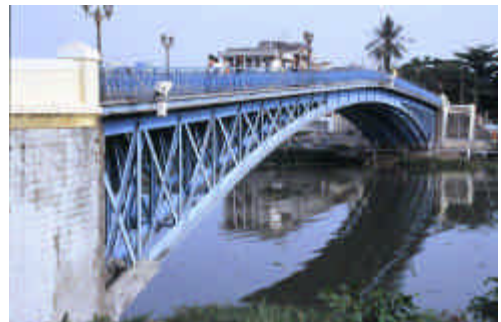
モン橋(上流側) : モン橋は、門橋」の意味。いつ、なぜ、橋名が変わったのだろうか。
