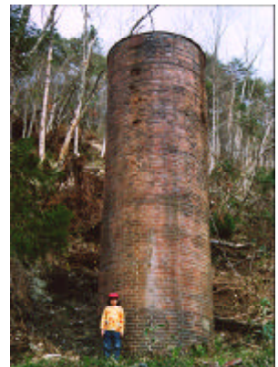
板谷峠トンネルの排煙用煙突
