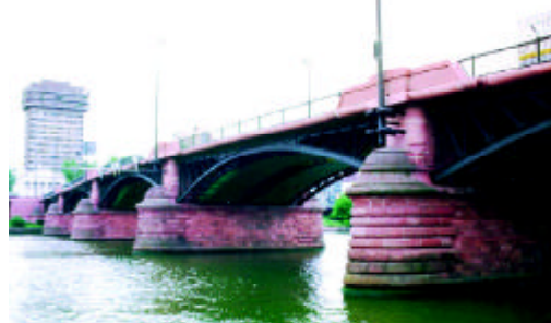
歩道部に鉄橋が再生したオーバーマイン橋
