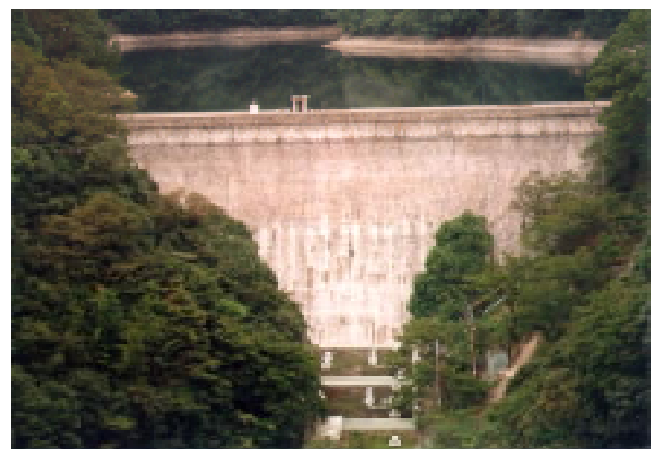
現在の布引ダム（正式には五本松堰堤）
