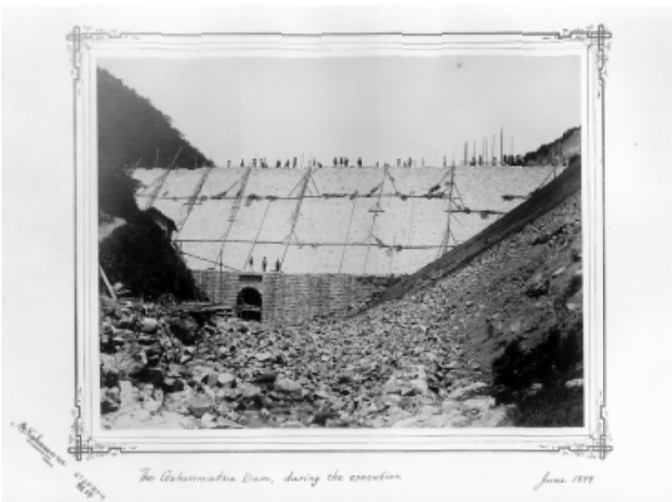
建設中の布引ダム (1899)
