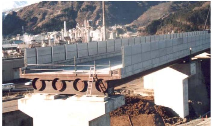
図-1 コンクリート充填鋼管橋
