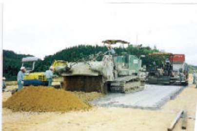
スタビライザによる路床改良(安来道路)
