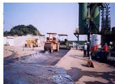
転圧状況 (ロードローラー)
