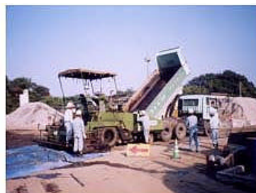
敷均し状況 (アスファルトフィニッシャー)
