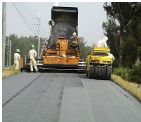
道路路盤材としての施工状況
