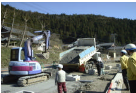
路盤材撒き出し状況
