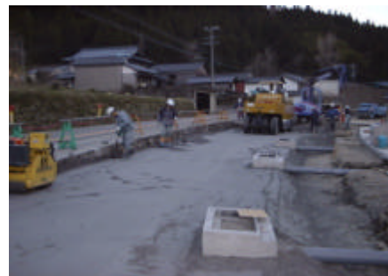
路盤材締固め状況
