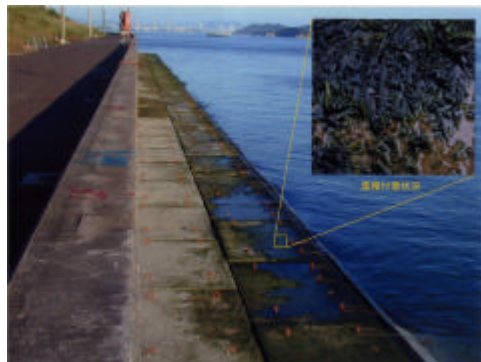
鉄鋼スラグ水和固化体を用いた護岸補強工事完成直後の概観（被覆ブロックに藻類付着）
