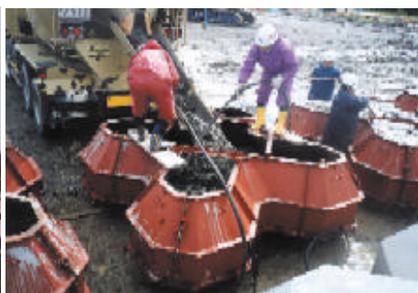
シュート打設（ブロック）
