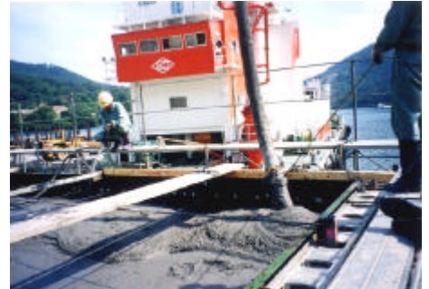
ポンプ打設（上部工） 有スランプ打設
