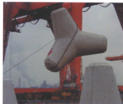
鉄鋼スラグ水和固化体を用いた ブロック施工状況 (資料提供：J-power)
