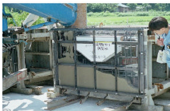
フライアッシュ高流動コンクリート
