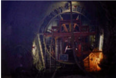
打設状況 (資料提供: J-power)
