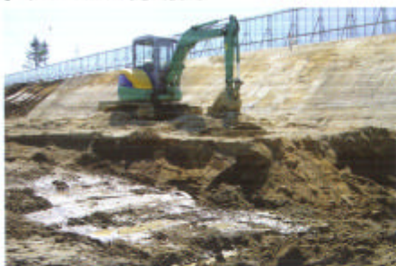
高含水比不良土などの軟弱地盤に軟弱地盤改良材として「Fドライ」を利用できます。
