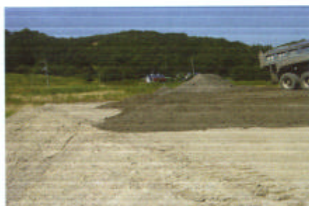
改良土は土木材料として活用できます。
