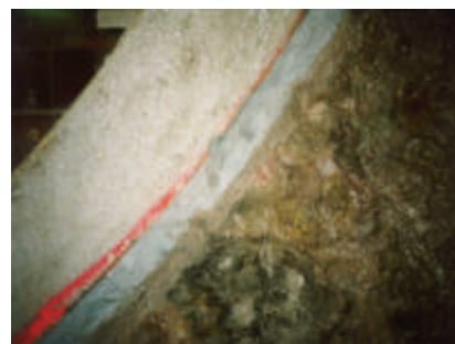
グラウト材充填状況
