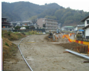
配管敷設状況 ・（配管：50×250m）
