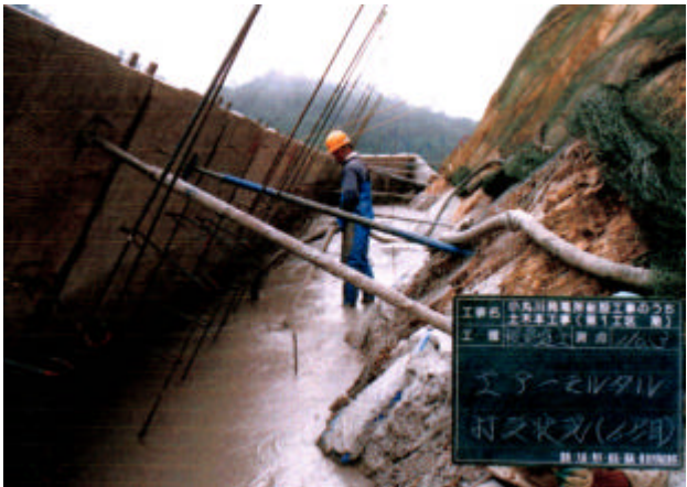
落石防護工施工状況 (使用実績 150t)
