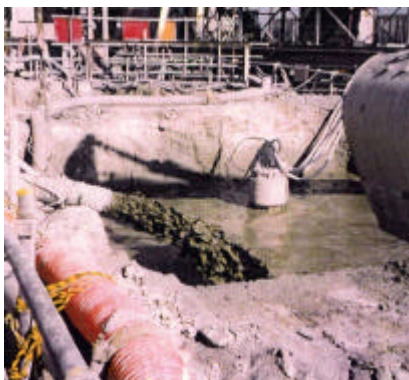
発生した建設汚泥
