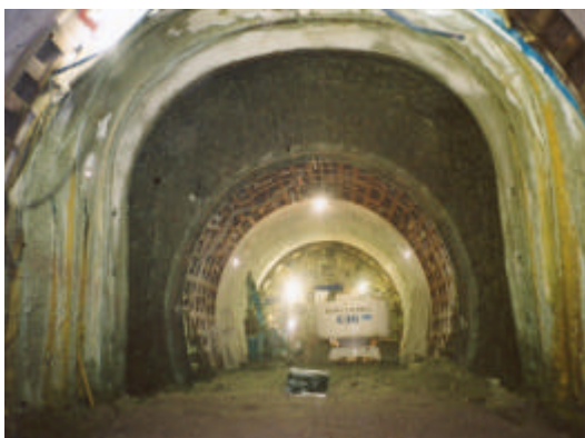
グラウト材充填状況
