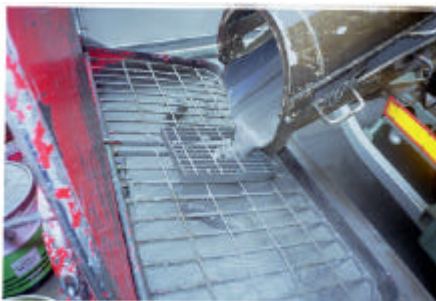
写真 2 コンクリートポンプ車投入
