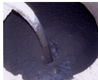
エアミルクの注入状況 （旧マンホールからの注入）
