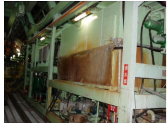
裏込め注入プラント (坑内)
