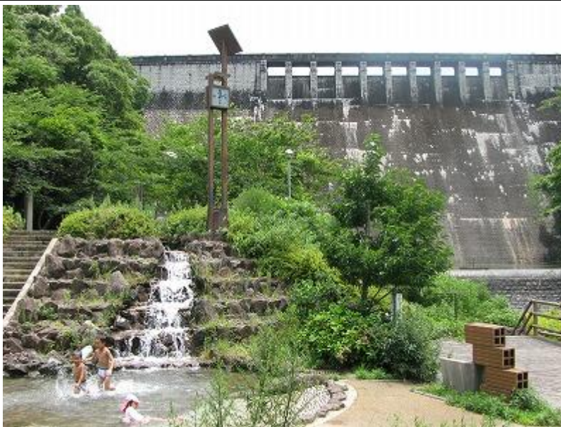
小ヶ倉（水道）堰堤
