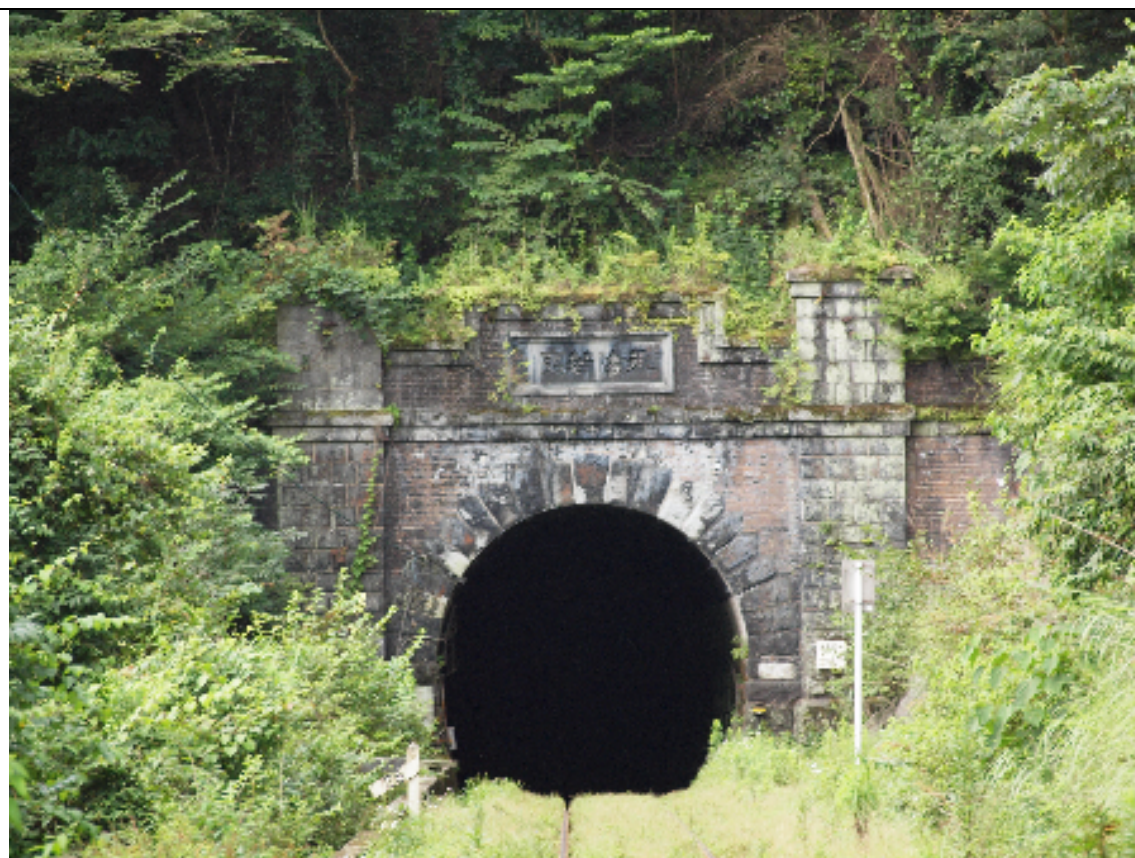
矢岳第一トンネル
