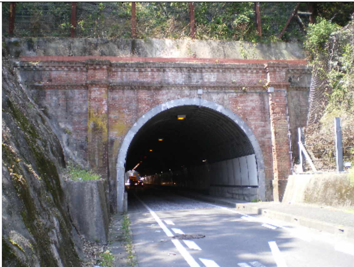
小坪隧道・名越隧道
