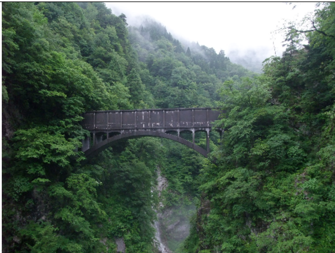
柳河原発電所 跡曳水路橋
