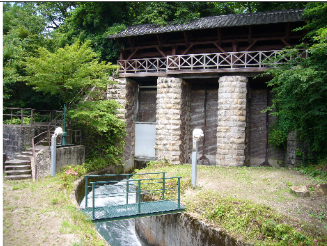
七ヶ用水 大水門および給水口
