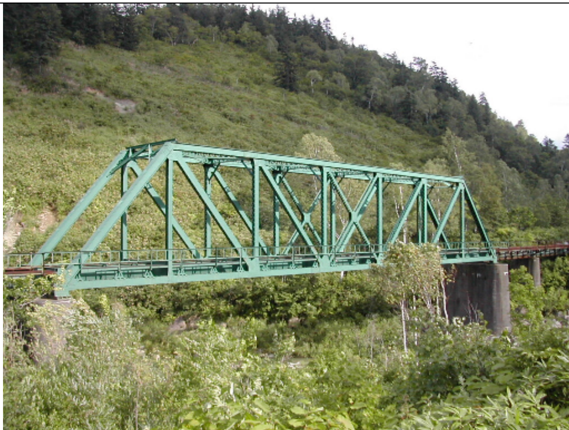
第三雨竜川橋梁
