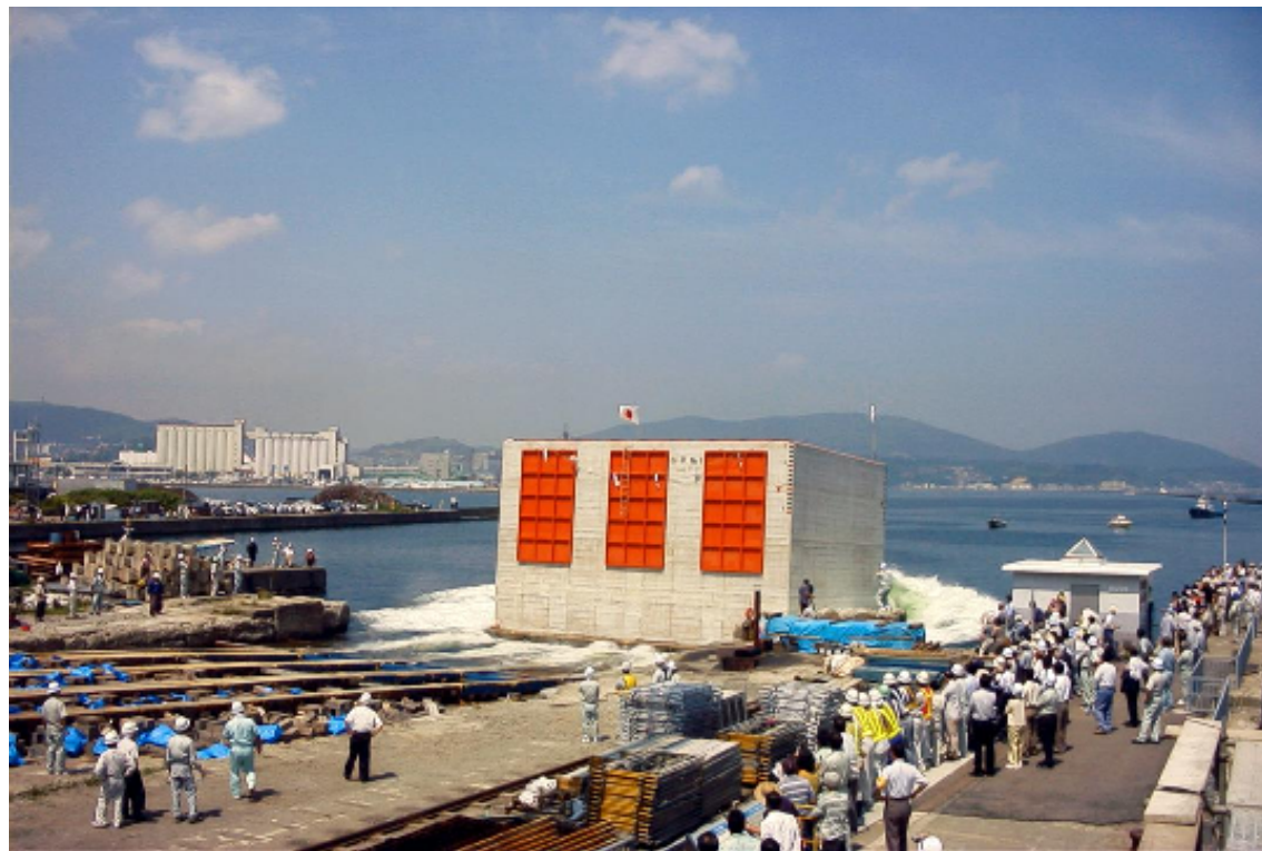
小樽港斜路式ケーソン製作ヤード
