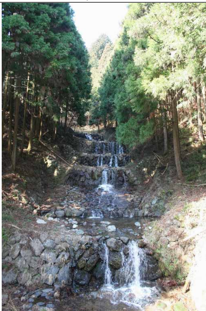
七重川砂防堰堤群
