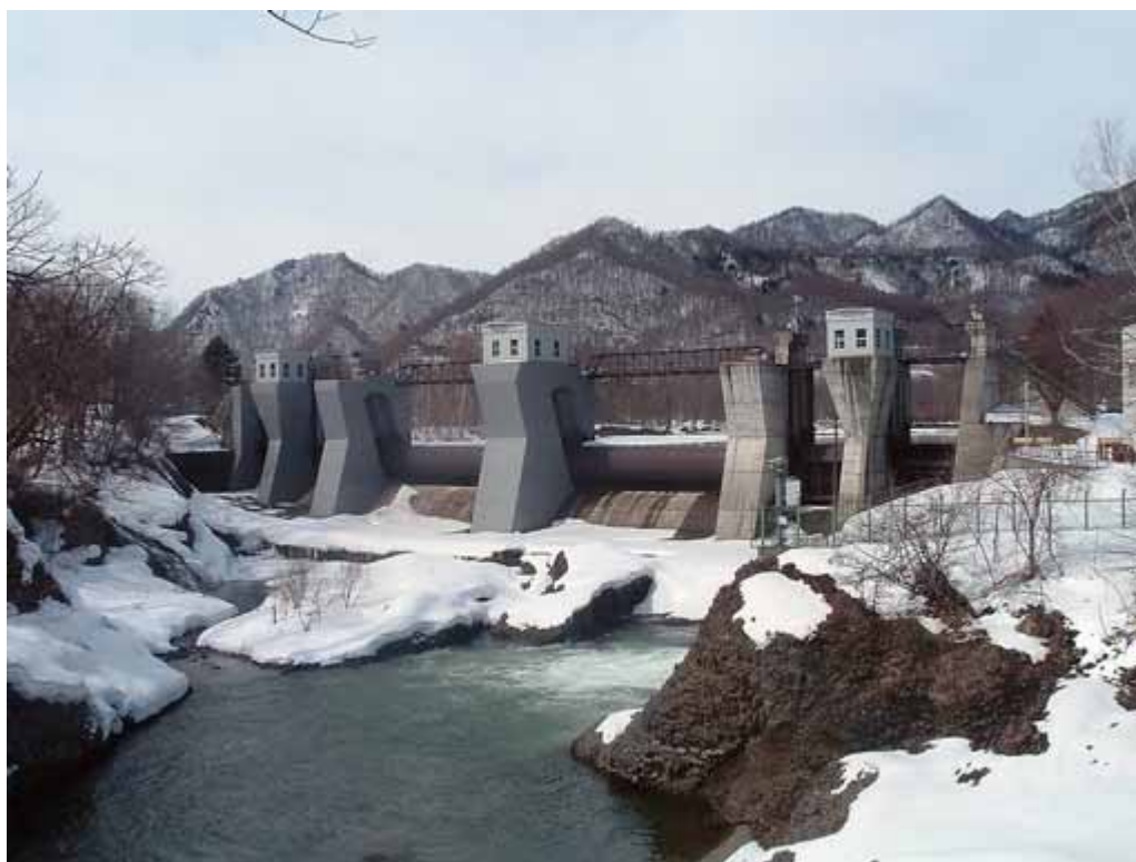
藻岩発電所・取水堰
