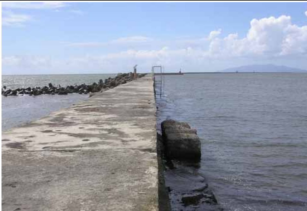
土崎港関連施設
