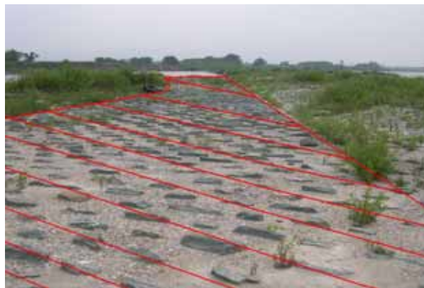
写真V-1 第十堰上堰に残る「喰い違い堰」
