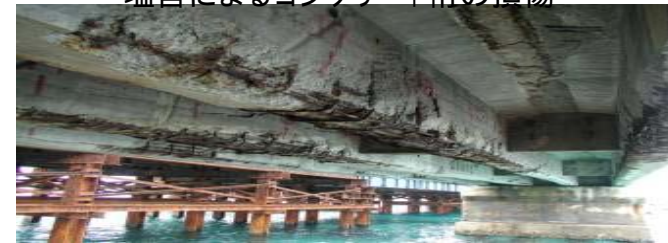
地方管理橋梁
