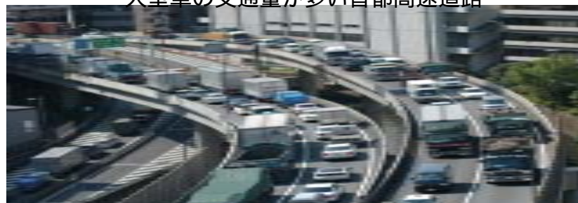
大型車の交通量が多い首都高速道路
