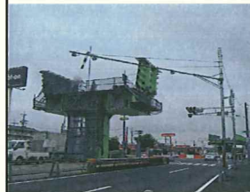
交差点部で桁を移動している状況(夜間施工で、2車線を確保して施工)
