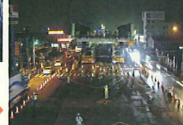
交差点部で桁を移動している状況(夜間施工で、2車線を確保して施工)
