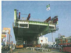
移動多軸台車(台車上に桁を受けるペントが設置されている状況)
