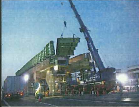
地組された1径間分の橋桁が、移動多軸台車へ積載された状況
