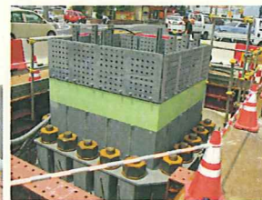
▲橋脚(鋼製1本柱)の下端ブロックの据付状況
