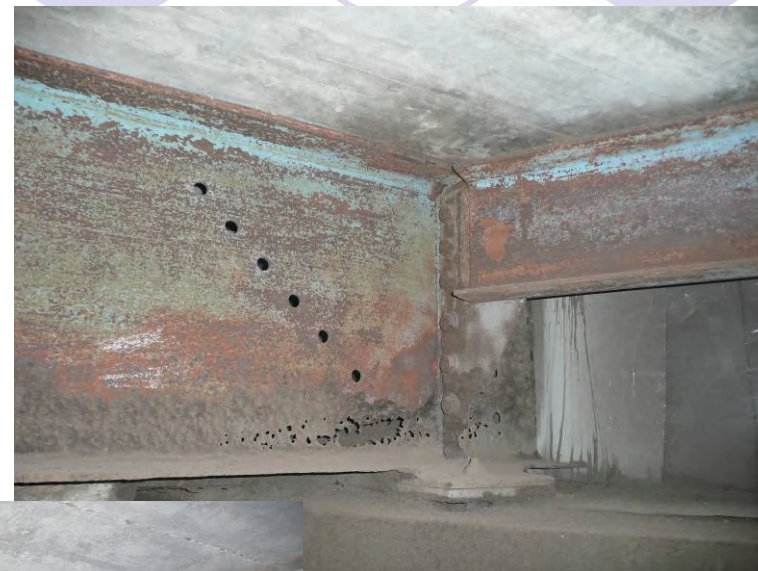
従来程度の施工
