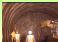
写真-4. トンネル内でのCMR(手前)の活動状況
