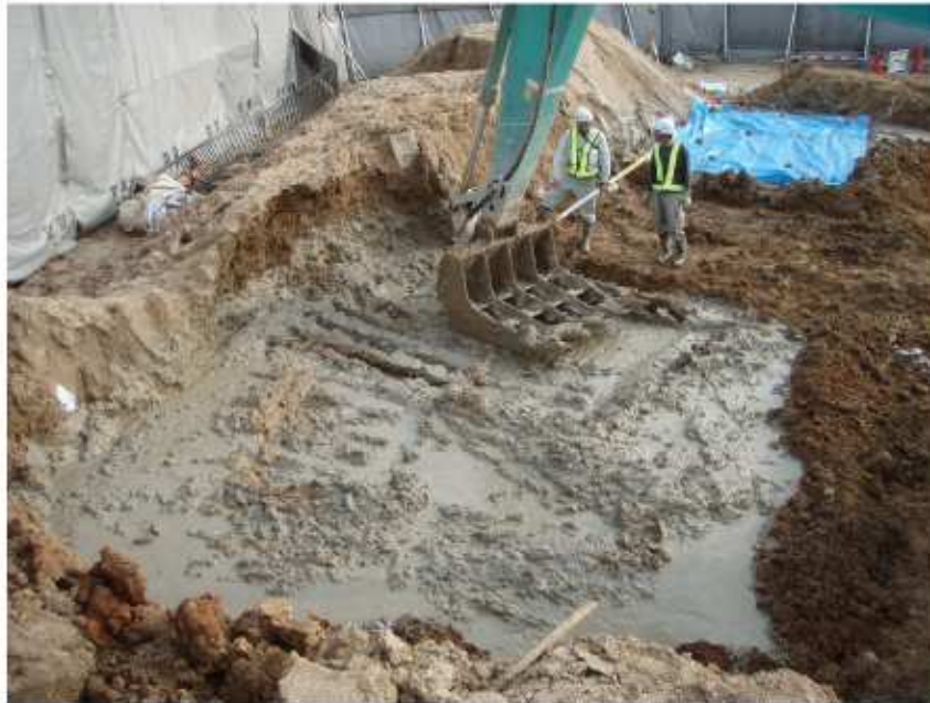
写真1 地表面からの地盤改良施工
