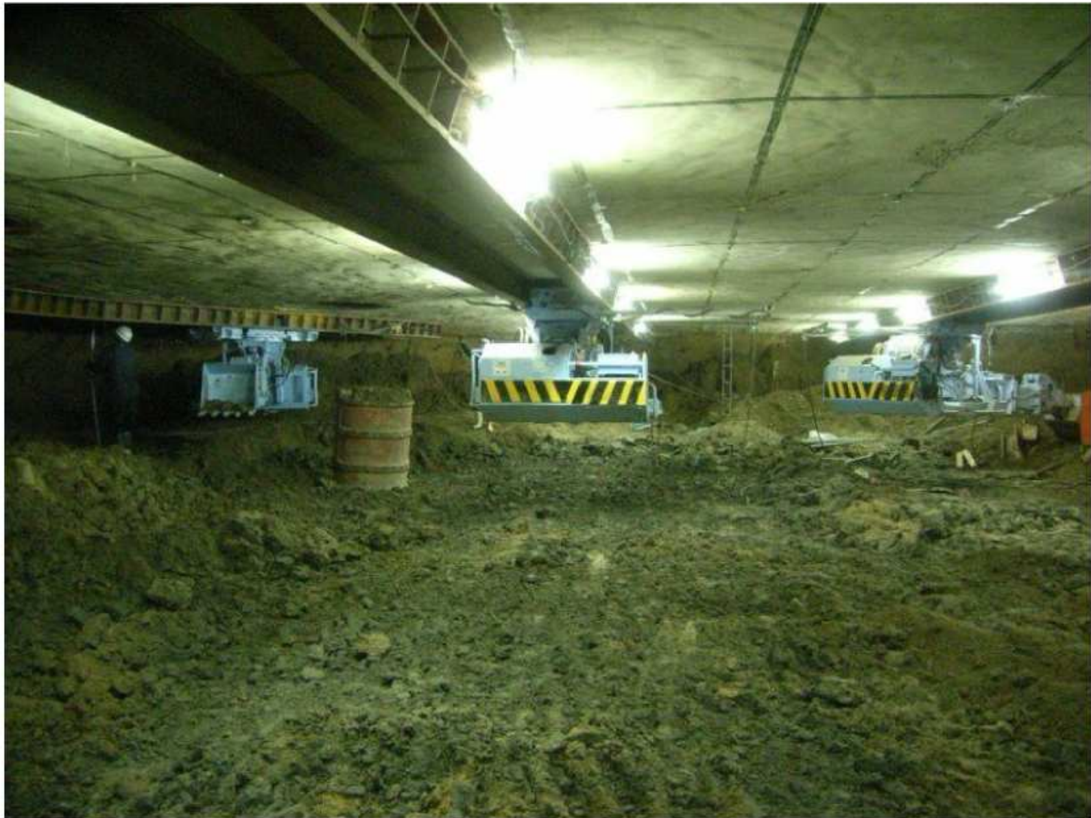
写真3（作業室内掘削状況2）
