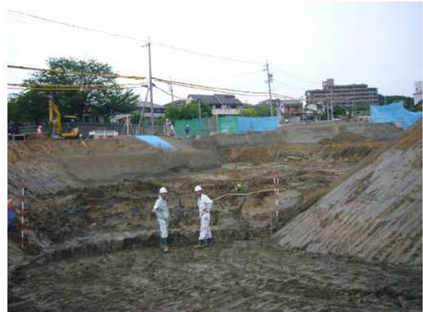
写真2 施工ヤード、坑口部の施工
