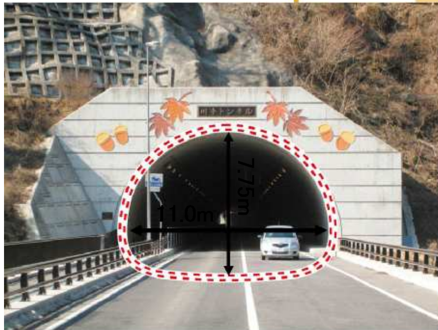
国道257号 川手トンネル 通称“メロディートンネル” (豊田市稲武地区)
