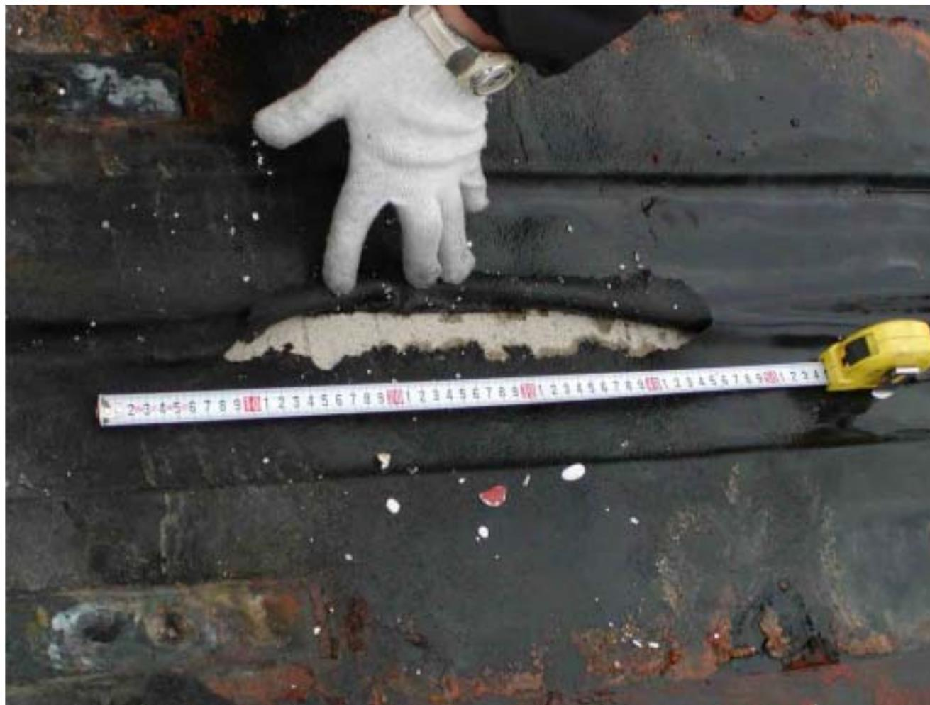
写真 2-4 ケーソンNo. 11-12 防砂板表面の拡大写真(海側表面)
