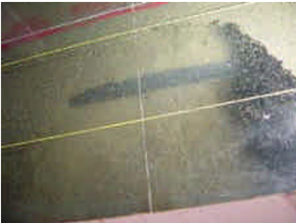
参考写真9 水道管の状態
