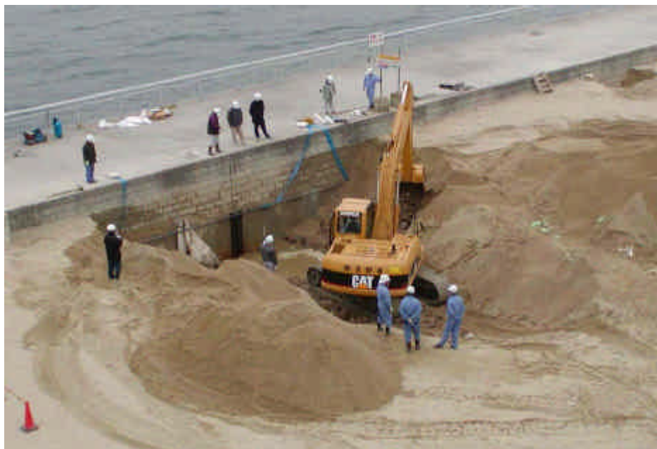
掘削調査状況 (南側突堤)
