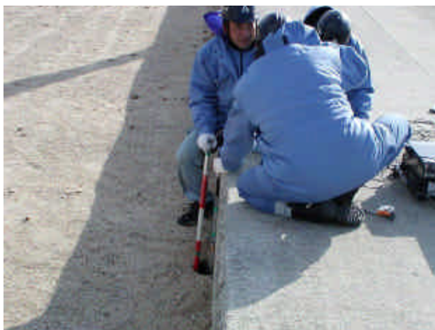
南側突堤 №5-6 ケーソン目地部
