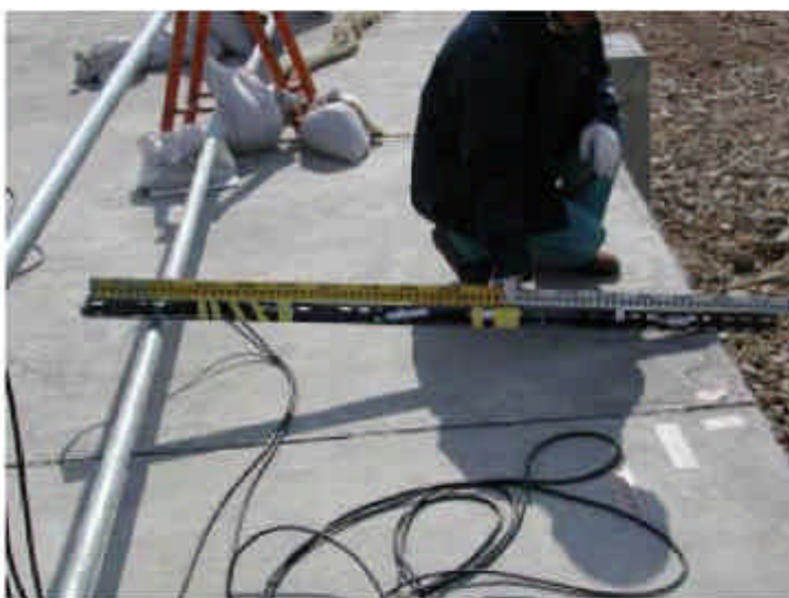
間隙水圧計の 架台への取付状況
