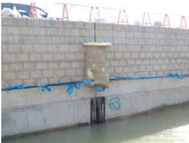
写真－3.3 発泡ウレタン注入による空洞の型取り
