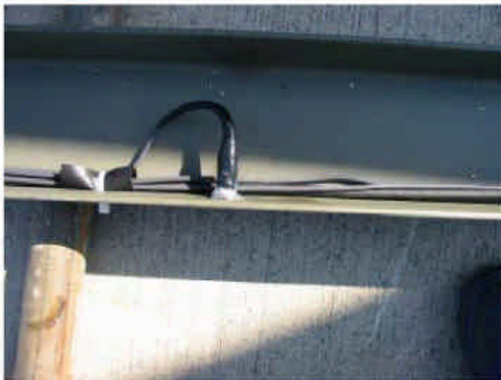
波圧計の取付架台 への取付状況
