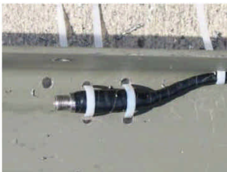
水位計の架台 への取付状況
