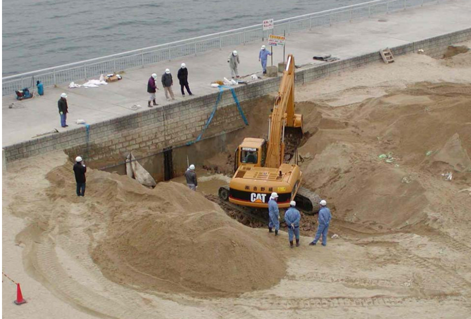
掘削調査状況 (南側突堤)
