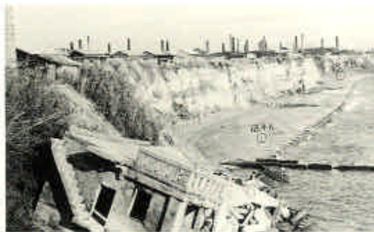
写真-2.1 侵食によって崩落した工場(江井ヶ島海岸)
